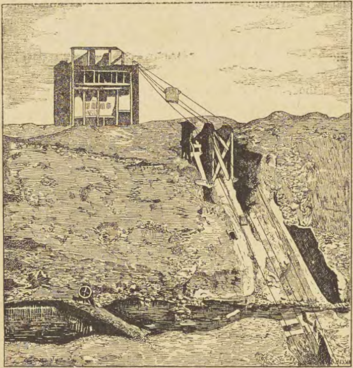
Fig. 28. — Vue d'une installation pour le transport du minéral diamantifère par tramways aériens.
